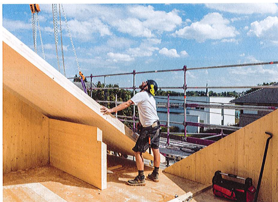
De houtstructuren worden tot op de millimeter nauwkeurig gemaakt. Elke opmeting moet dus 100% precies zijn. (Beeld: Marble Moon)
