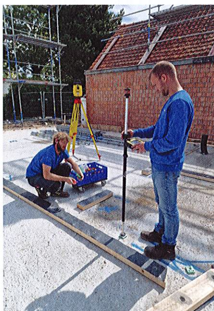
Op elke werf wordt het robotstation ingezet en dat zowel bij de opmeting als bij het uitzetten van de werken.
